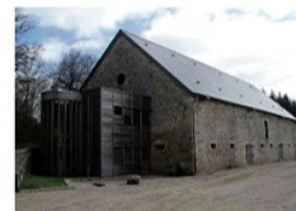
Salle de congrès, ajout de locaux techniques en bois [Clergoux, H. Turlier, architecte]
