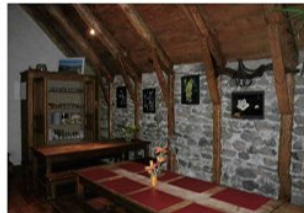
Gîte de groupes, charpente d'origine avec jambages ennoyés (Saint-Victor-la-Rivière 63)
