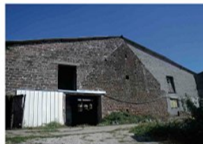
Grange ayant connu deux extensions au 20 e s. [Lanteuil]
