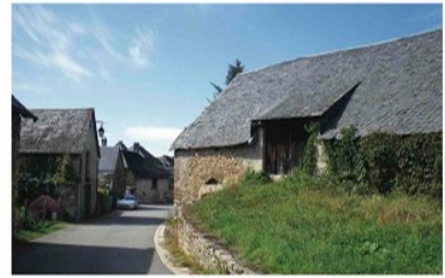
Il n'y a pas un village qui ne comporte une grange désaffectée à l'avenir incertain [Lapleau]
