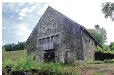
Partie centrale du pignon reconstruite [Habitation à Saint-Pierre-Roche 63]
