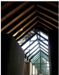
Eclairage dit "zénithal" [Auvers 48, P. Jarlier, architecte]
