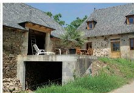
Terrasse sur garage enterré [Monceaux-sur-Dordogne]
