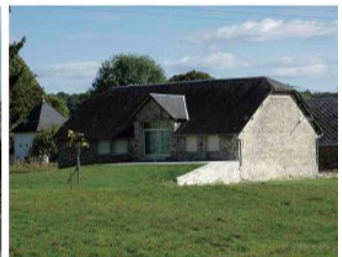
Accès de plain-pied à l'étage, (habitation à Favars)
