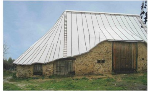
Grange ovale, classée Monument Historique en 1996, chantier de restauration en cours, bache provisoire en attente du chaume [Saint-Eloy-les-Tuileries]
