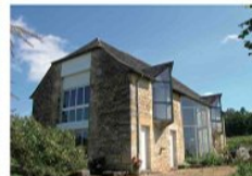
Verrières et bow-windows [Perpezac-le-Blanc, B. Puybouffat, architecte]
