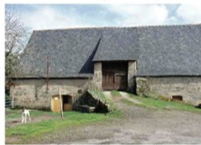
Grange auvergnate d'influence Cantal : une rampe procure un accès facile à l'étage (Camps-Saint-Mathurin)
