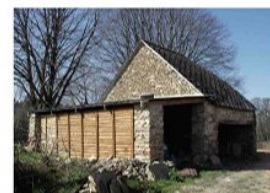
Ajout d'un garage [Sainte-Fortunade]
