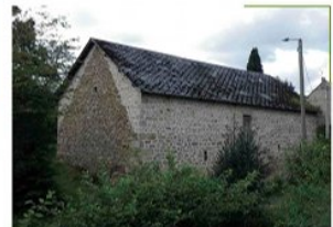
Grange réhaussée [Ambrugot]
