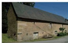
Ordonnement et hiérarchie très particulière des baies, grande dimension des blocs de pierre [Tarnac]
