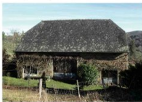
Grange limousine : toutes les portes sont de plain-pied en suivant la pente du terrain (Saint-Hilaire-Peyroux)
