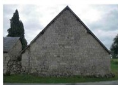
Appareillage en blocs irréguliers mais parfaitement ajustés, pignon aveugle, débord de toit limité à dix centimètres [Ambrugeat]
