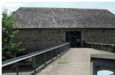
L'ancienne levée de grange a été aménagée pour l'accès de plain-pied à la salle polyvalente. On a employé des galets caractéristiques des berges de la Dordogne.
