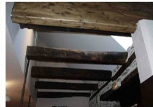
Maison du patrimoine, solivage partiellement dépourvu de son plancher pour laisser passer la lumière (Argentat, P. Brudieux, architecte)
