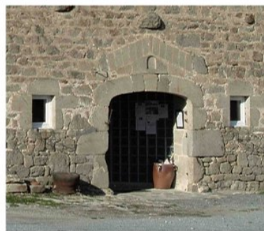
Créperie, l'entrée est réalisée en retrait de l'ancienne porte d'étable, de façon à ménager un abri et mettre en valeur l'encadrement en granite (Ligniac)
