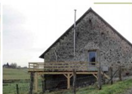
Terrasse discrète, tout en bois [Bassignac-le-Haut]
