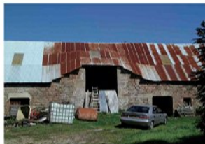
Grange du 18 e s. couverture de tôles en remplacement du chaume [Pérols-sur-Vézère]
