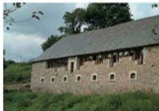
Eclairage dit "en attique", sous forme de bande vitrée juste sous le toit, soulignant le rythme de la charpente [Rosnay 36, J. Quatrepoint, architecte, Ydes 15, P. Dumond, architecte]
