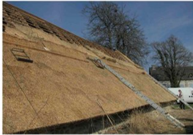
Une action de sauvegarde exemplaire [chantier 2010] : grange à charpente cruck, recouverte en paille de seigle conformément à la tradition en haute-Corrèze. [Saint-Fréjoux, A. Klavun, chaumier]
