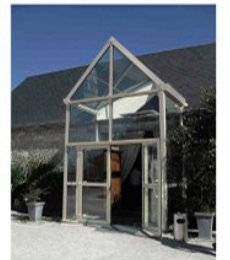
Le sas vitré souligne le portail charretier et apporte une lumière zénithale en englobant une partie du toit. [Domaine de Russac, Turenne, J.L. Roullin, architecte]
