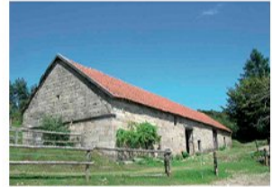
Grange du 17 e s. couverture de tuiles mécaniques en remplacement du chaume [Chaumeil]
