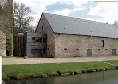
Salle de congrès, domaine de Sédrières, Clergoux, H. Turlier, architecte
