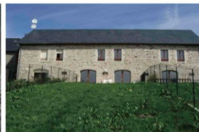
Trois nouvelles ouvertures à l'étage [Logements sociaux à Lestards, D. Monteil, architecte]
