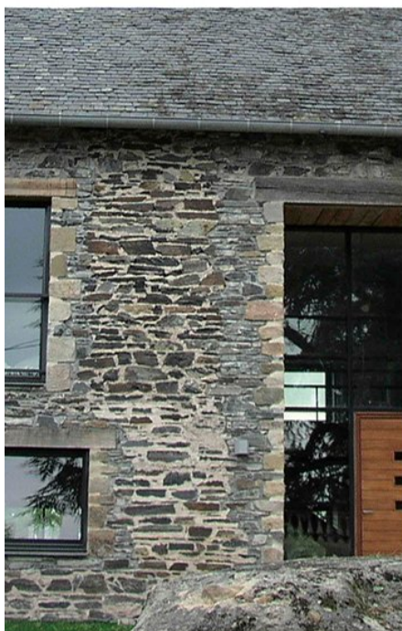
Création et modification d'ouvertures, linteaux faits de poutres de récupération [Ussac]
