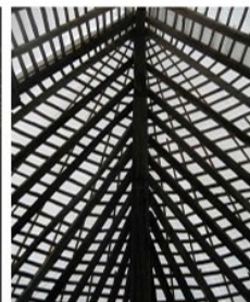
Réfection à l'identique de la charpente, grange ovale classée aux Monuments Historiques (Saint-Eloy-les-Tuileries, S. Manculescu, ACMH)
