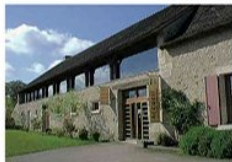
Eclairage dit "en attique", sous forme de bande vitrée juste sous le toit, soulignant le rythme de la charpente [Rosnay 36, J. Quatrepoint, architecte, Ydes 15, P. Dumond, architecte]
