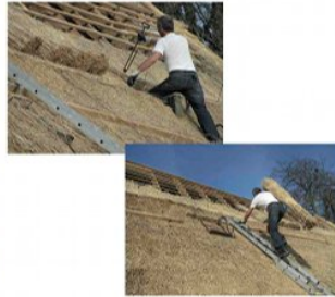
Une action de sauvegarde exemplaire [chantier 2010] : grange à charpente cruck, recouverte en paille de seigle conformément à la tradition en haute-Corrèze. [Saint-Fréjoux, A. Klavun, chaumier]
