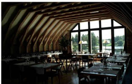
Restaurant dans l'ancienne fenièrre, charpente refaite à l'identique (Auriac, H. David, architecte)
